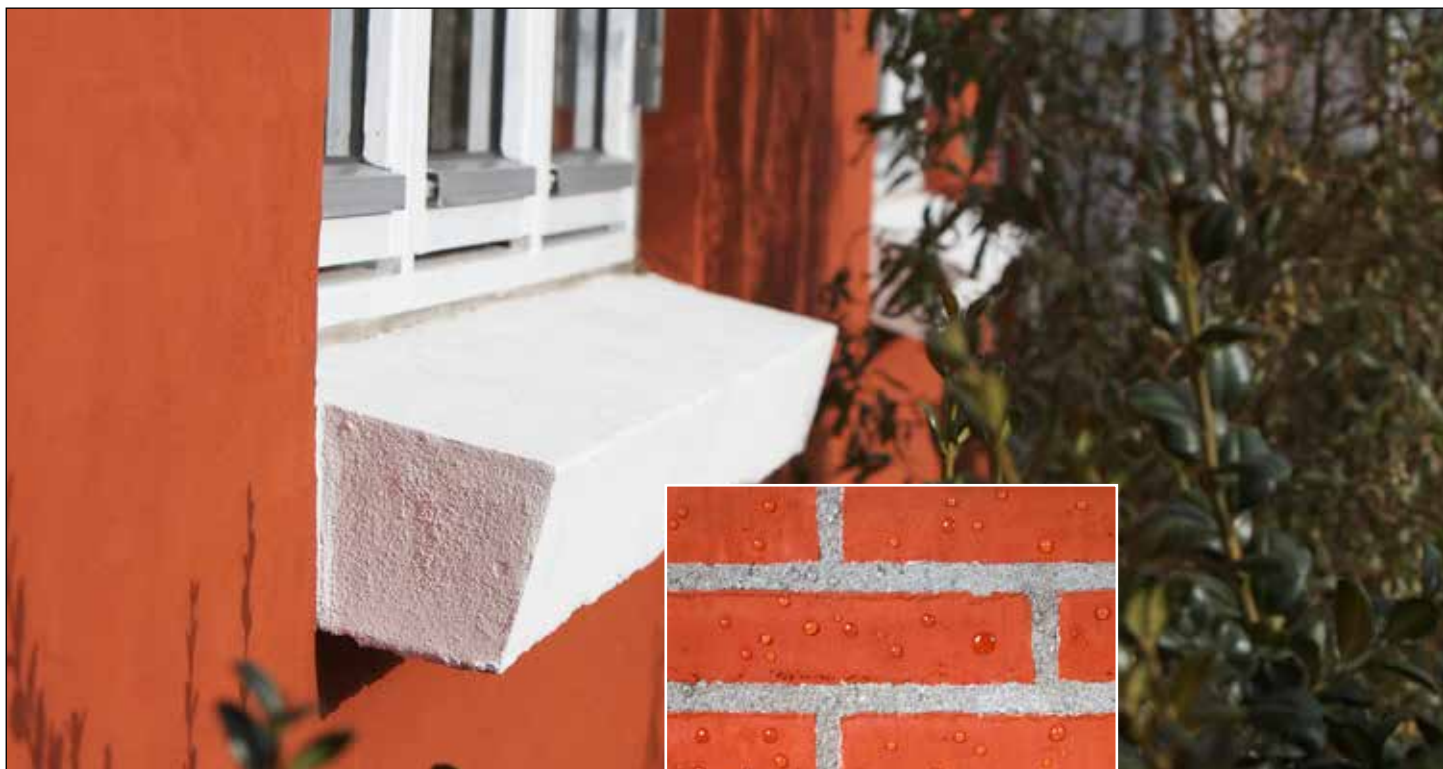
»Vandperle-effekt« på imprægneret overflade
